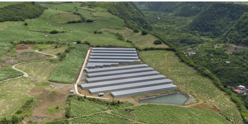
Agri 5 – Serres agricoles à couverture semi- photovoltaïque La Réunion – 1,4 MWc
