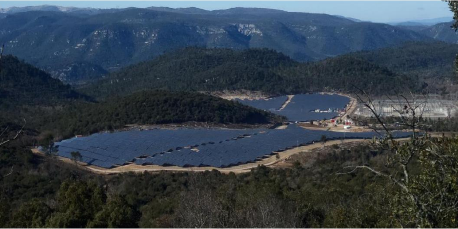
Verrerie – Raccordé au réseau en haute-tension (230 kv) – Var – 2x12 MWc
