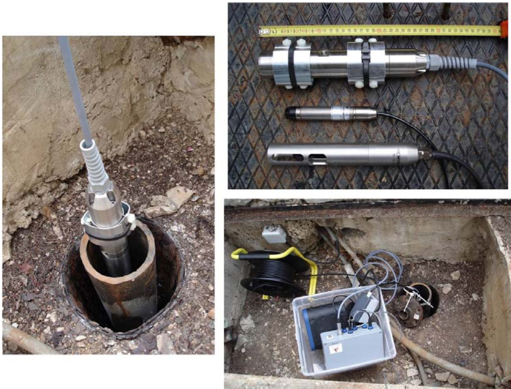
Figure 4- 19 : Sondes de conductivité-température, pression-température et fluorimètre-turbidité installées dans le forage de Bestouan. Le dispositif est plus simple qu'à Port-Miou, à l'air libre, avec moins de sondes, un datalogger sur place, et une prise électrique à disposition.
