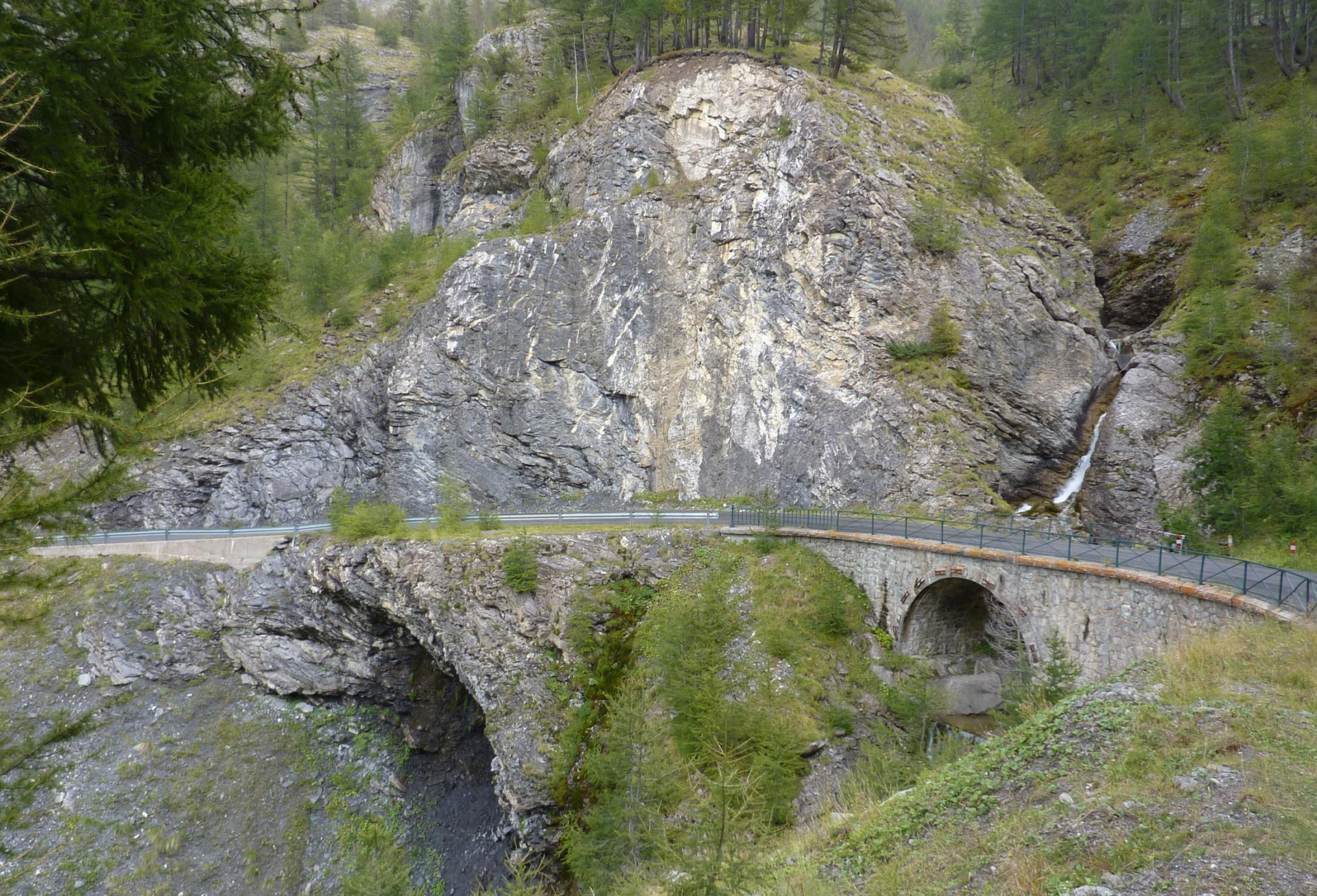
55 D - Bachelard-Pont de la cascade : calcaire brèche du Crétacé sup. sur marne albo-aptienne = faille normale synsédimentaire probable
