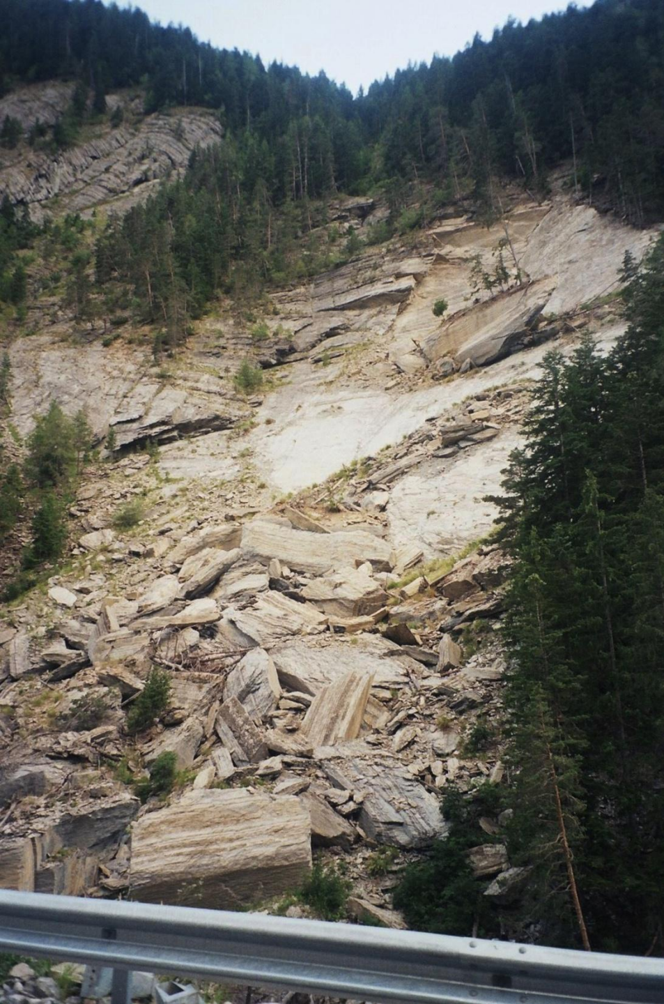
28 D C - Gorges du Bachelard sortie amont, glissement récent du Flysch, à contre pendage, sur des plans de fractures et de schistosité, ayant occasionné l'obstruction du lit (vers 2008)
