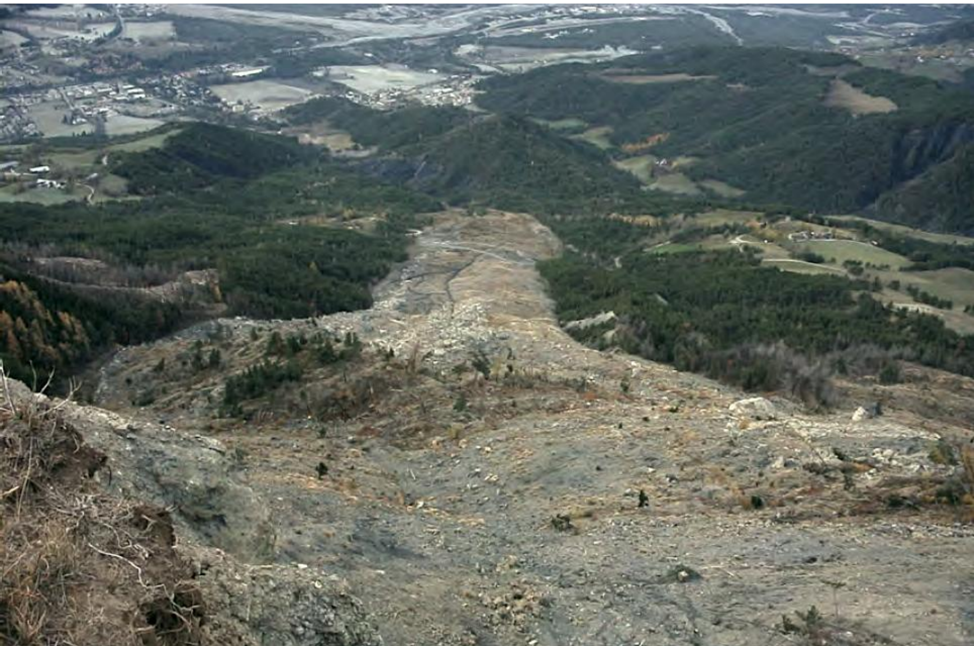
4b V C - Sommet du glissement de La Valette en 2004 (doc. PPR de Barcelonnette)
